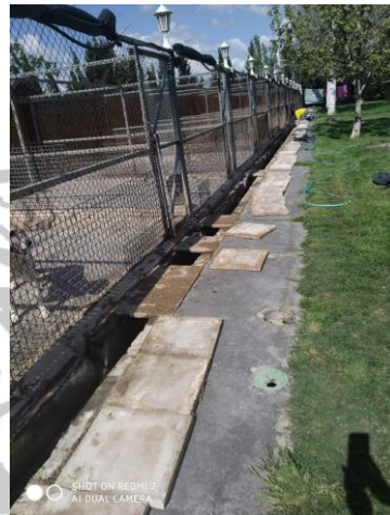
Limpieza desagües cheniles
